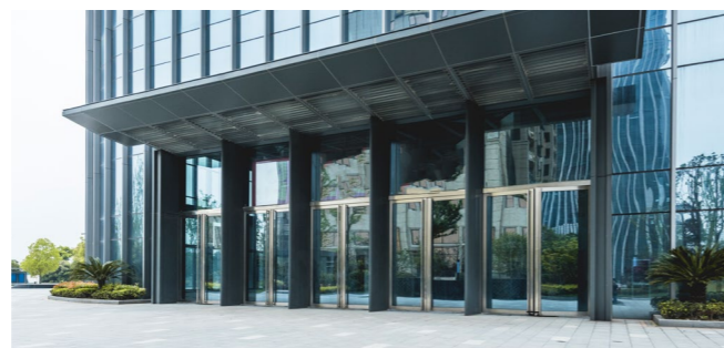
Realizzazione di infissi e facciate
